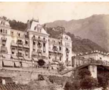
Das Gebäude rechts vom Grand Hôtel, Verbindungstrakt zwischen diesem und dem Hôtel des Alpes, beherbergte schon damals den grossen Speisesaal für beide Hotels, der später durch den Sisi-Prachtssaal ersetzt wurde. Bild: Collection Riolo
