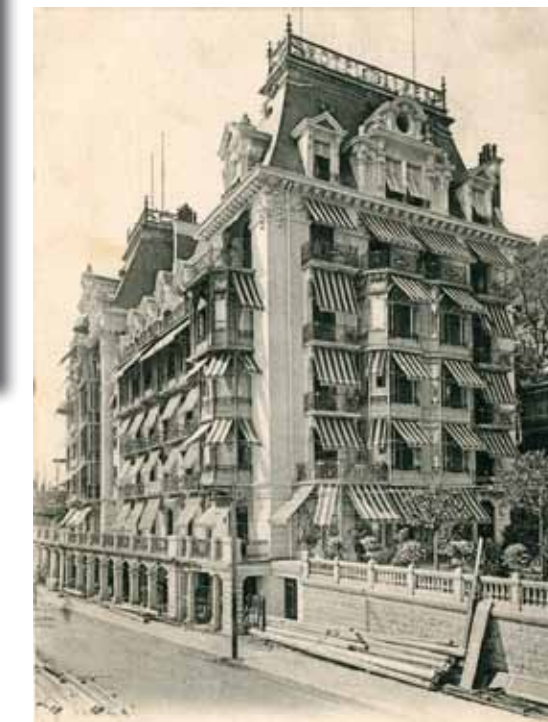
Und immer wieder wurde modernisiert: Das neue Hôtel des Alpes in Konstruktion (1904/05). Bild: Collection Riolo
