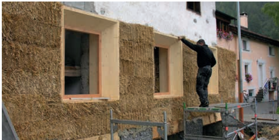
Baustoffe aus nachwachsenden Rohstoffen verursachen deutlich weniger Treibhausgasemissionen. Dieses Foto zeigt das Projekt «Haus P&W» oder «Casa Steila Mar» in Susch, bei dem die Aussenfassade mit Stroh thermisch saniert wurde. © Atelier Schmidt
