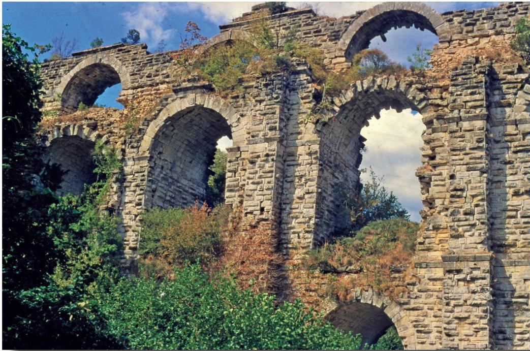
Die zweistöckige Kurşunlugerme-Brücke des Aquädukts von Konstantinopel: Über diese Brücke führten zwei Wasserkanäle – einer über dem anderen.
