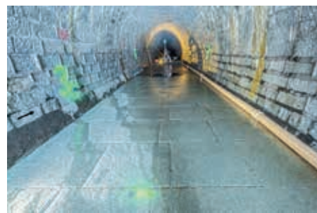
Der Umleitstollen am Stausee Pfaffensprung im Kanton Uri wurde bereits mit Granit verkleidet. (Bild: ETH Zürich)
