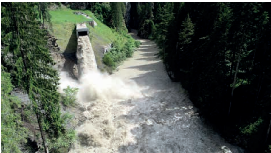
Der Umleitstollen am Solis-Stausee in Graubünden. (Bild: ETH Zürich)
