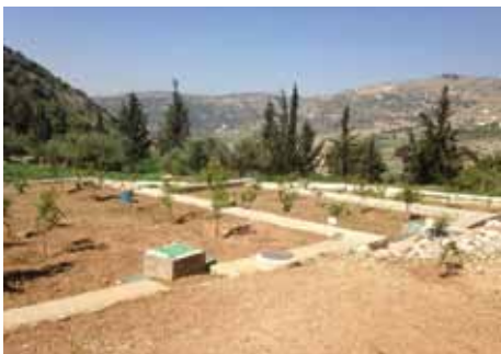
Dezentrale Brackwasserentsalzung für Trinkwasser und Landwirtschaft, Karameh, Unteres Jordantal, Jordanien © Martin Sauter
